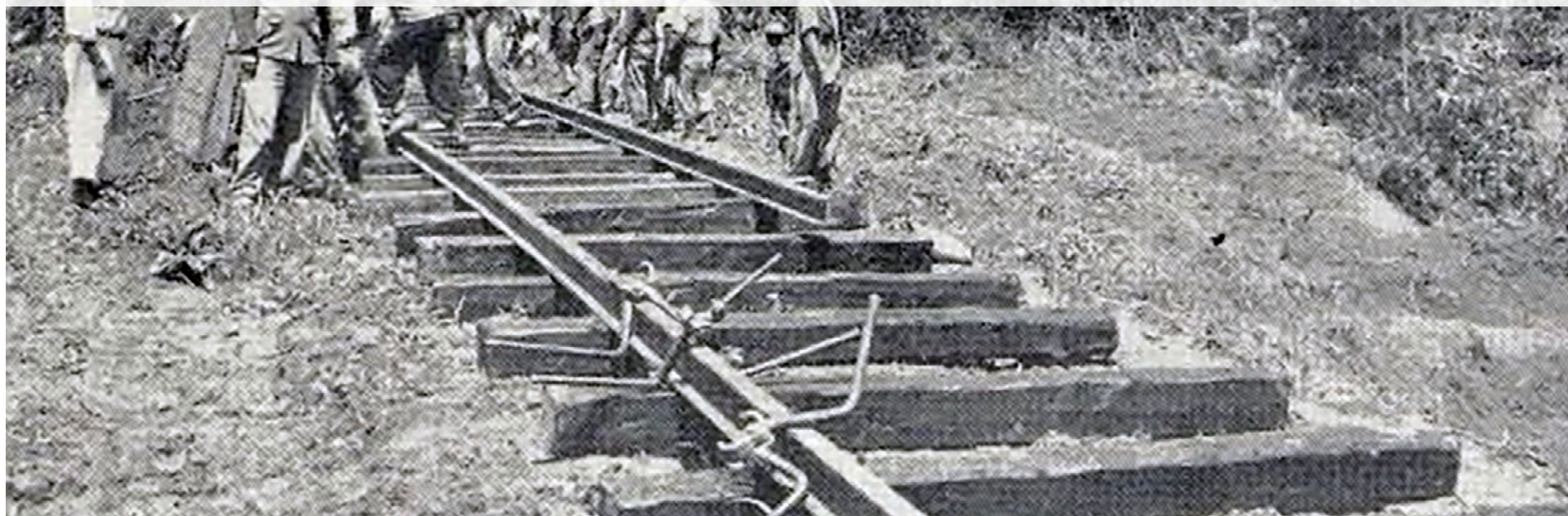
Armado de rieles y durmientes. Fuente: Ferrocarril del Sureste, op. cit.
