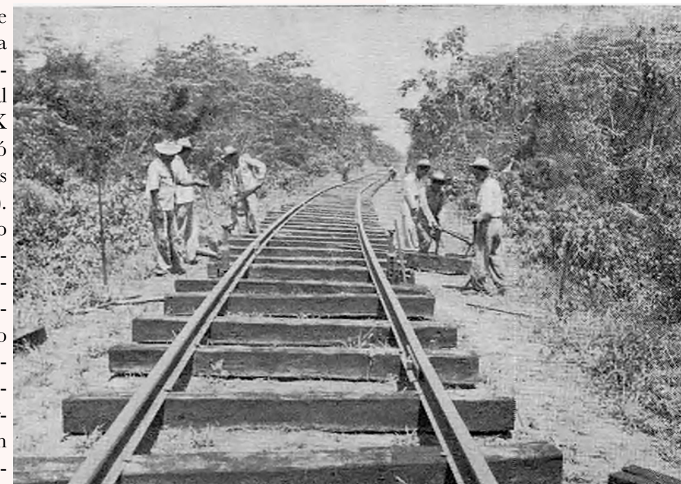
Durmientes y trabajadores. Fuente: Ferrocarril del Sureste, op. cit.
