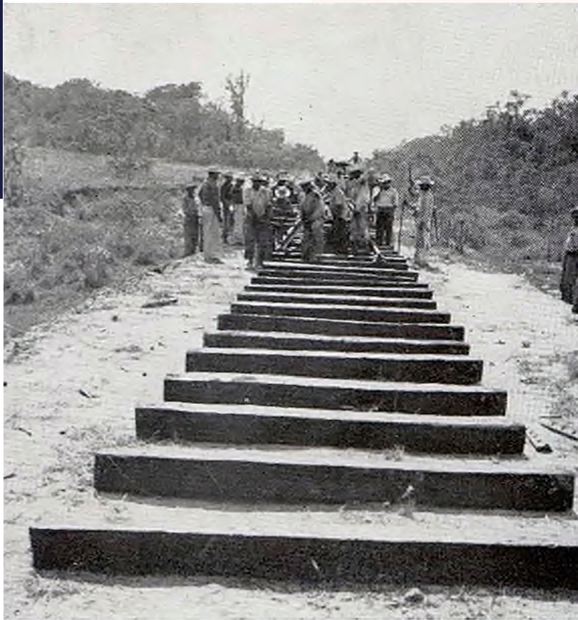
Los durmientes de madera dura eran labrados con hacha. Fuente: Ferrocarril del Sureste, op. cit.
