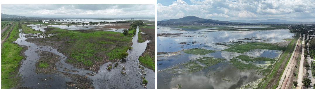
Imagen 7. Vuelo de Dron, entrada de agua del Canal de Santos Tomas a la Laguna de Zumpango. Foto: Aram León
