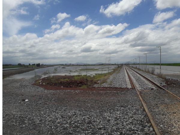
Imagen 4. Obras del NAICM en el Lago de Texcoco
