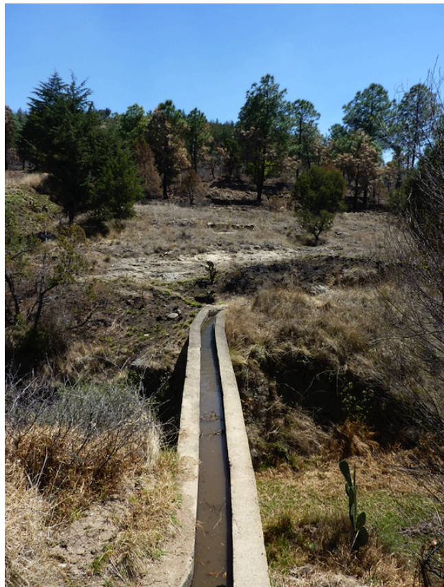
Imagen 2. Canal en San Nicolás Tlaminca construido sobre trazo prehispánico, Unidad de Riego “Barranca Temexco”.
