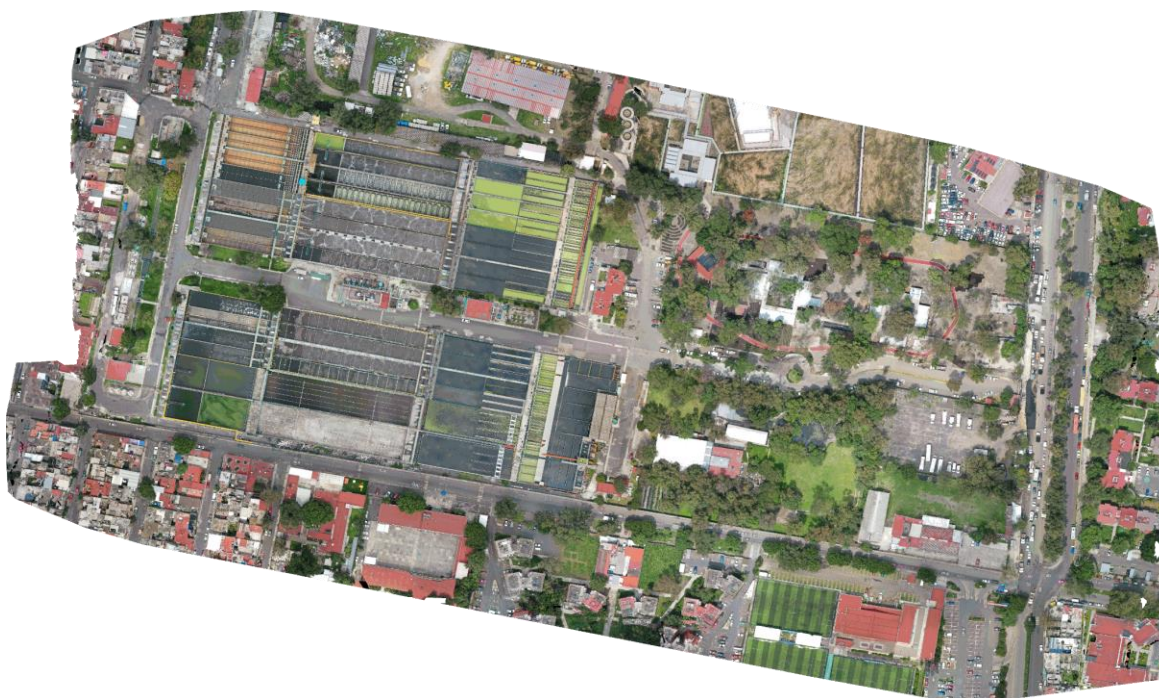
Figura 16 Ortofoto de la Planta de tratamiento de aguas residuales Cerro de la Estrella.
