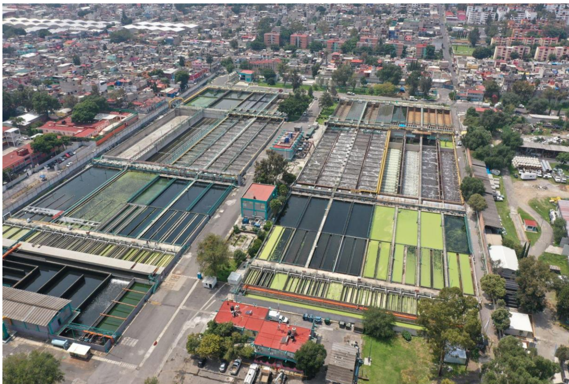
Figura 15 Vista aérea de la Planta de tratamiento de aguas residuales Cerro de la Estrella.
