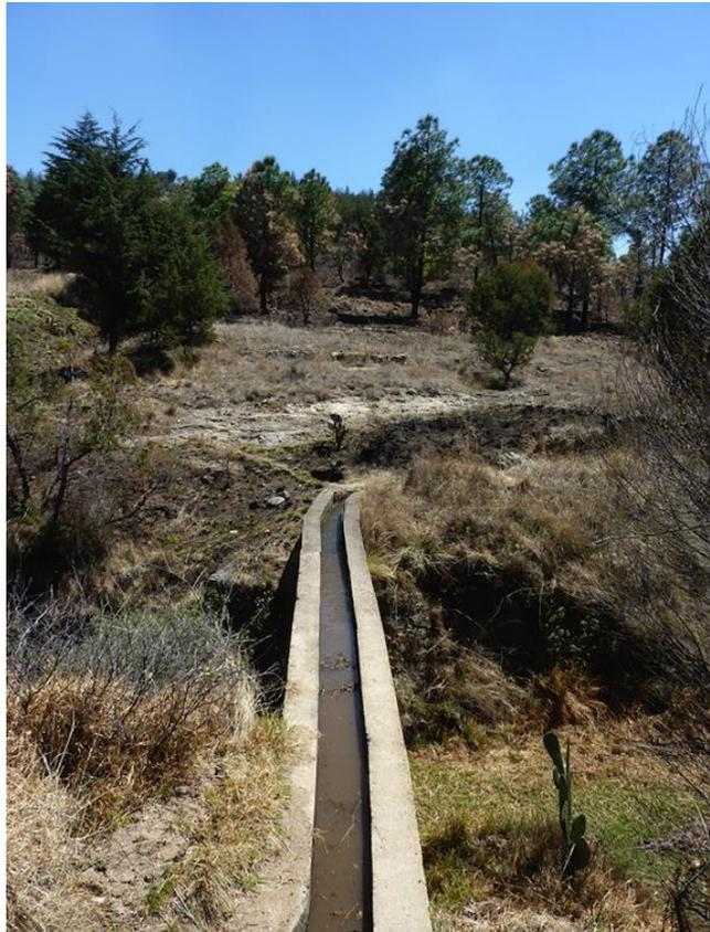
Figura 2. Canal en San Nicolás Tlaminca construido sobre trazo prehispánico, Unidad de Riego “Barranca Temexco”.
